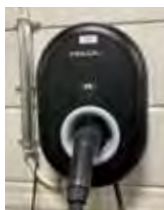
En option: borne de recharge Wallbox avec câble de rechargement Type 2, A464548
